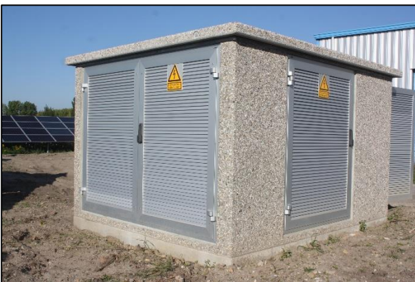
Figure 6 : Exemple de postes de transformation (Crédit photo : ENERPARC, 2019)
