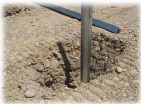
Figure 5 : Types de fondation - pieux battus (Source : Guide MEDDTL 2011 – NCA, 2015)
