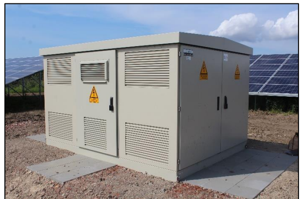
Figure 6 : Exemple de postes de transformation (Crédit photo : ENERPARC, 2019)
